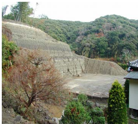
▲ついに工事完工
